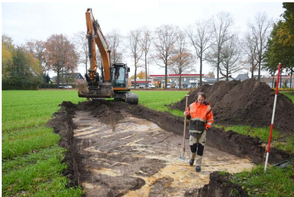
Fig. 2. Mierlo-Luchen-Burgemeester Termeerstraat. De aanleg van een proefsleuf, met op de achtergrond het tankstation aan de Geldropseweg.
